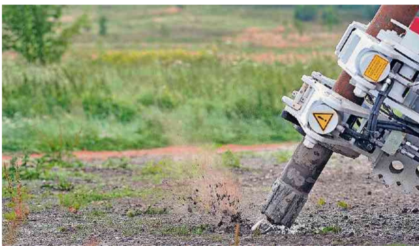
Bohrung für eine Erdsonde.
